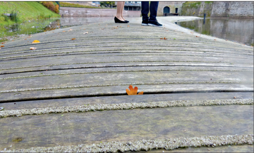
Diese einzigartige Schwimmbrücke, deren gebogene „Accoya“-Dielen, die zu beiden Seiten bis ins Wasser reichen, den tragenden Luftschlauch verbergen, führt über den Wassergraben einer historischen Festung aus dem 18. Jahrhundert in Bergen op Zoom (Niederlande). Damit die Fußgänger nicht von den meist feuchten Dielen seitlich ins Wasser rutschen, sind die glatten Dielen auf dem Laufweg mit rutschhemmenden Sandstreifen versehen
