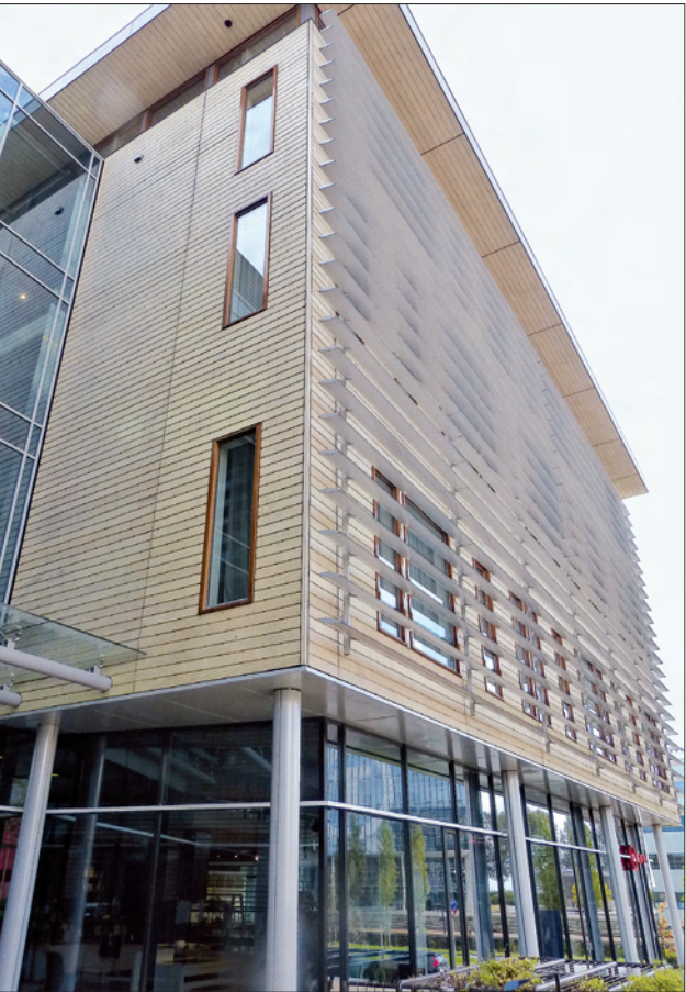
Bei diesem neuen Gebäude („Inspiration House“) im „Park 20 20“ in Hoopdorp, gleich neben dem Flughafen Schiphol, wurden Fenster und Fassade aus dem acetylierten Holz hergestellt. Das Gebäude beherbergt Büros und Ausstellungsräume von fünf Anbietern von Haushaltsgeräten: Bosch, Siemens, Gaggenau, Neff und Solitaire
