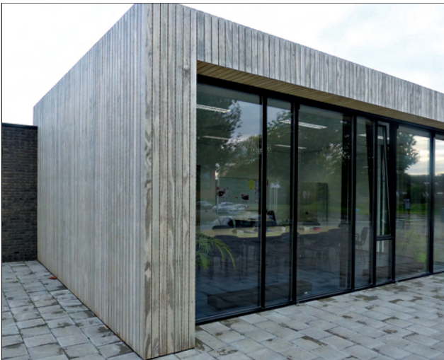
Als Fassadenverkleidung für die Erweiterung der Pomona-Schule in Bergen op Zoom (Niederlande) wurden 150 m² nicht weiter behandelte „Accoya“-Bretter verbaut. Das Holz zeigt nach gut einem Jahr lediglich Vergrauung und fühlt sich weiter sehr glatt an
