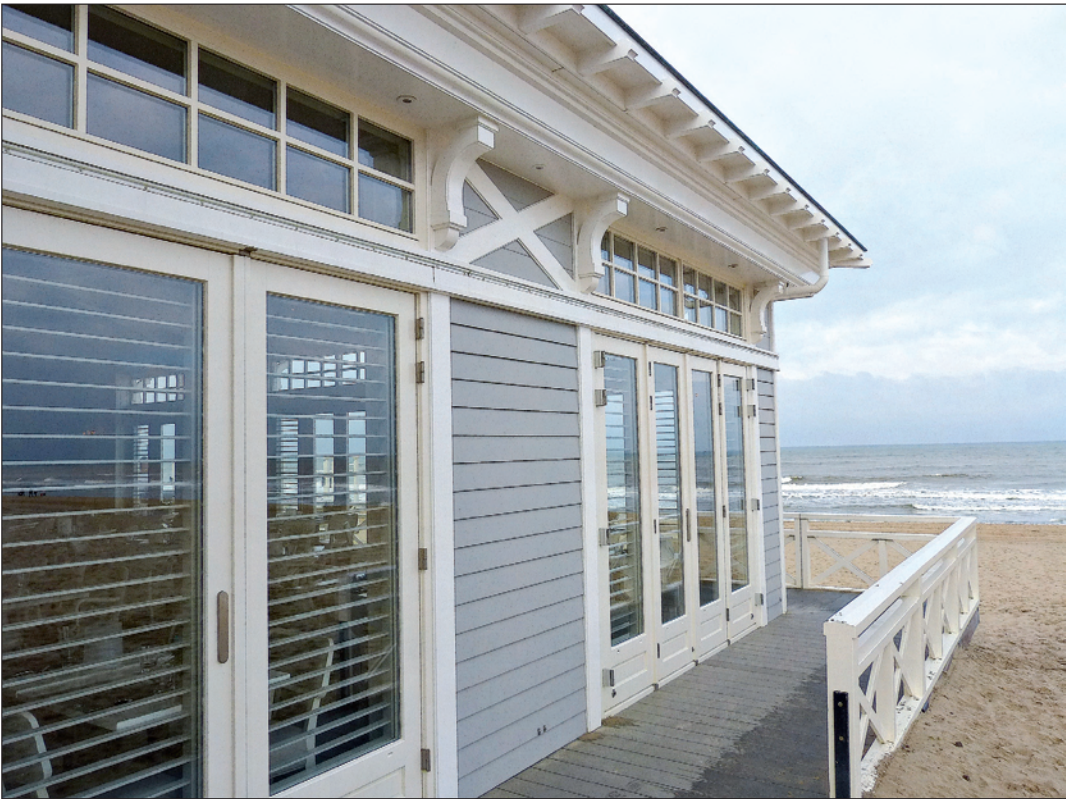
Das luxuriöse Strandhaus, das zum Hotel „Huis Ter Duin“ in Nordwijk gehört und direkt am Nordsee-Strand liegt, wurde 2010 mit „Accoya“-Holz errichtet (Fenster, Türen, Fassade, Geländer, Pfosten und Pflanzbehälter). Der Anstrich zeigt keine Alterserscheinungen. Der Lackhersteller Sikkens hat für sein werkseitig aufgebracht „Natural Balance“-Beschichtungssystem, das dort zur Anwendung kam, eine Garantie von zwölf Jahren abgegeben Fotos: J. Krauhausen
