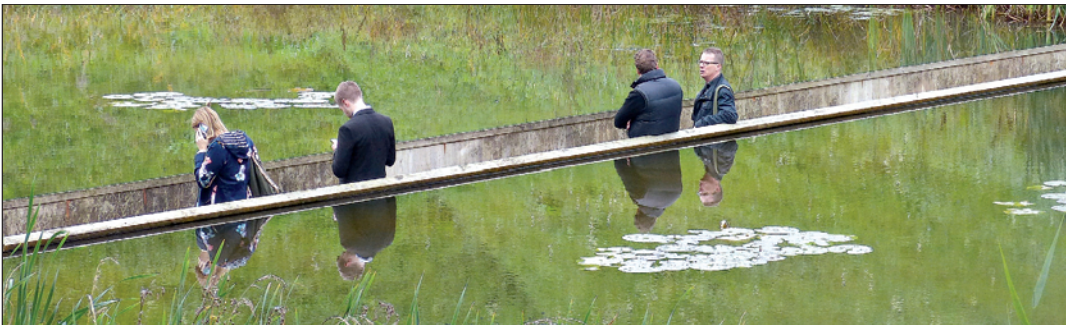
Diese 2010 gebaute „Moses-Brücke“ in Halsteren (Niederlande) erlaubt es, trockenen Fußes „durch’s Wasser“ zu gehen. Die „Brücke“ (eigentlich ein Laufgang) führt durch einen Wassergraben, der eine ehemalige Festung aus dem 18. Jahrhundert umgibt. Der Gang hat ein Beton-Fundament. Die Seitenwände und der Handlauf wurden aus „Accoya“ gebaut. Damit seitlich kein Wasser eindringt, ist vor Seitenwänden von der Wasserseite eine elastische Kunststoffolie angebracht. Im Winter wird der Wasserspiegel rund um die alte Festung übrigens so weit angehoben, dass die Moses-Brücke unter Wasser gerät und sich um die Festung eine Eisbahn zum Schlittschuhfahren bilden kann
