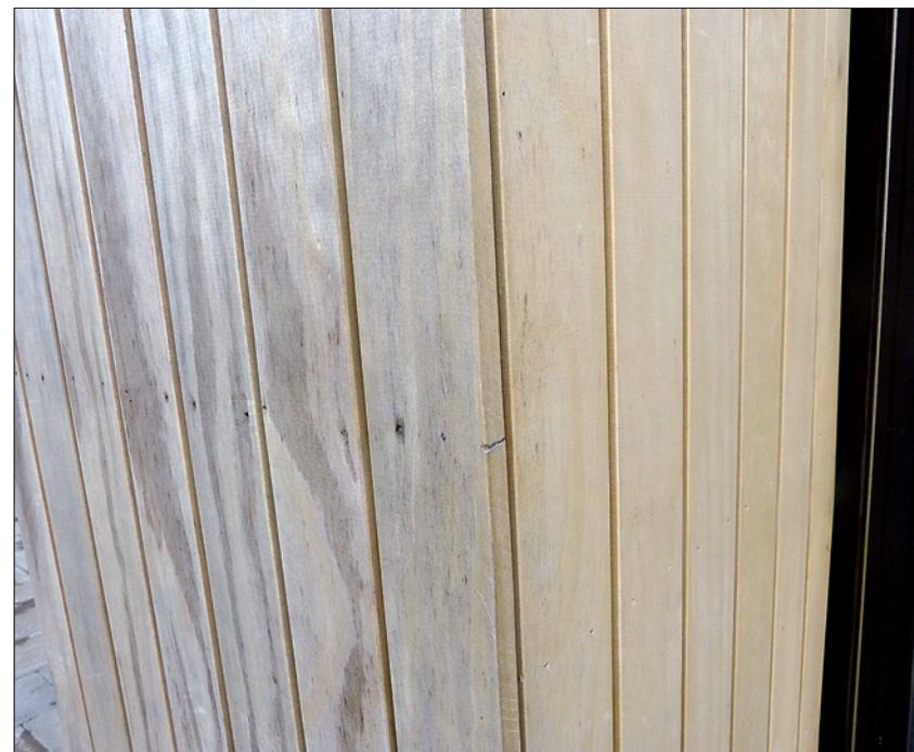
Diese etwa ein Jahr alte Schalung zeigt die Vergrauung von „Accoya“: links die voll bewitterte Fassade, rechts die Fassade im überdachten Eingangsbereich
